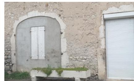
✗ Menuiseries en PVC, modification des ouvertures volets électriques roulants. Les caissons occultent une partie de la menuiserie et réduit la lumière des pièces intérieures.
