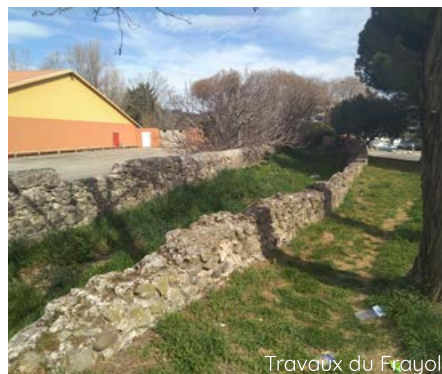
Travaux du Frayol
